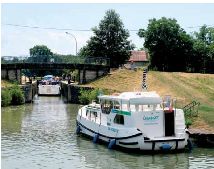
U plavebních komor jsou téměř vždy vývaziště pro čekání, než se komora uvolní.
